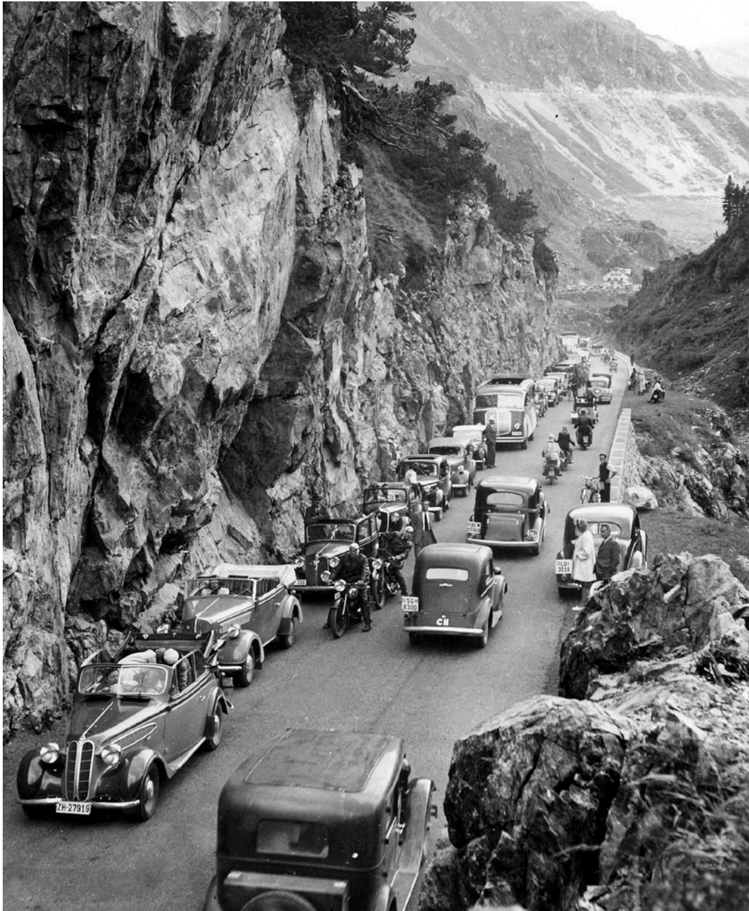
Neue Strassen schaffen neuen Verkehr: Die Sustenstrasse unterhalb des Hotels Steingletscher am 25. August 1946, zwei Wochen vor der offiziellen Eröffnung (Foto Oberingenieurkreis I, Tiefbauamt Bern).
