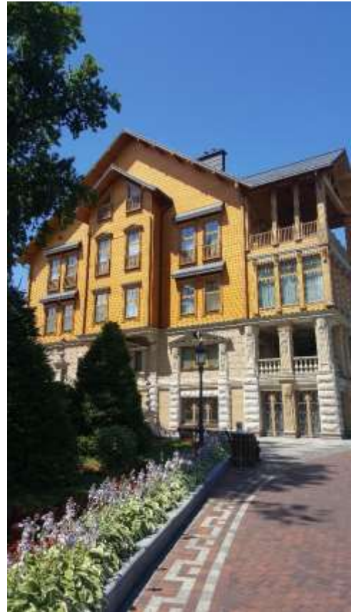
Abbildung 5: Hauptgebäude im Meschyhirja.
